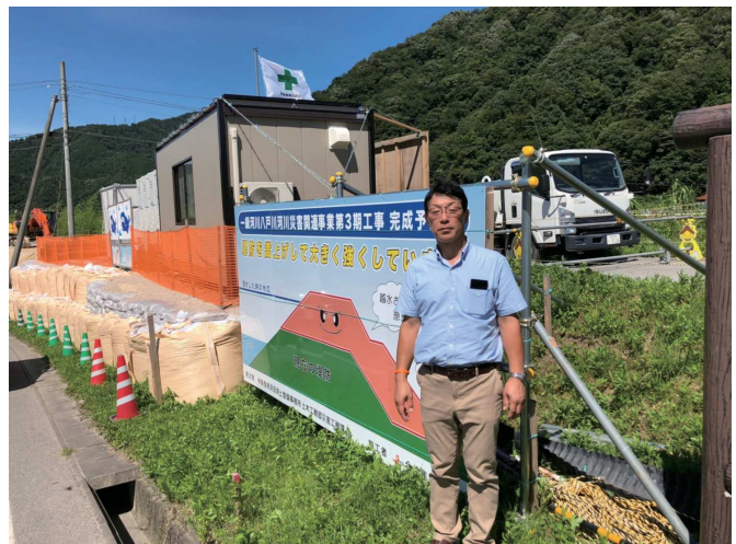
▲八戸川堤防かさ上げ工事
