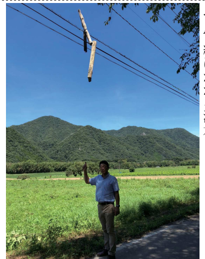
◀ 電線にかかる流木
