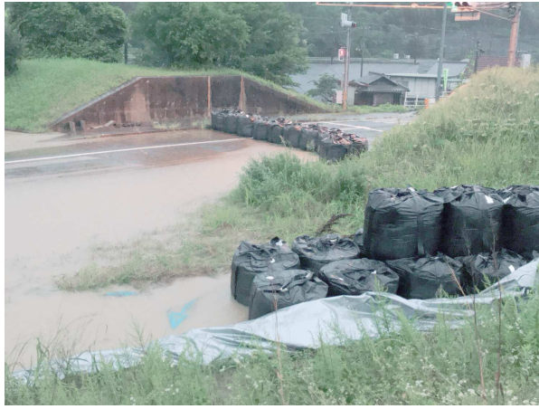
▲ 冠水した県道 倉敷清音線 (酒津地区)
